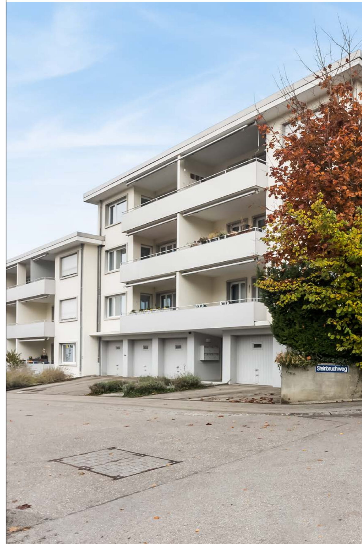
Liegenschaft Olten SO 12 Wohnungen 1961 (2019 totalsaniert)
