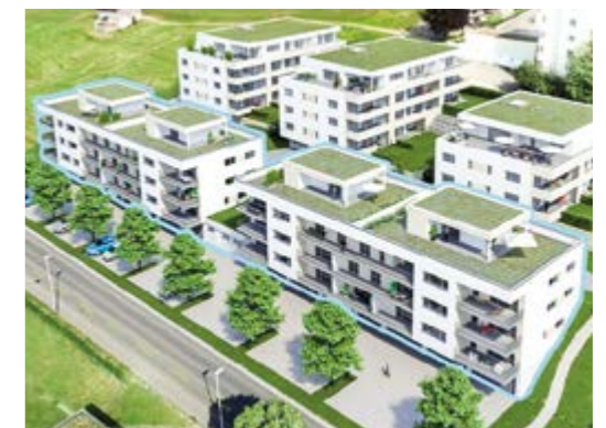
9620 Lichtensteig SG Loretostrasse
