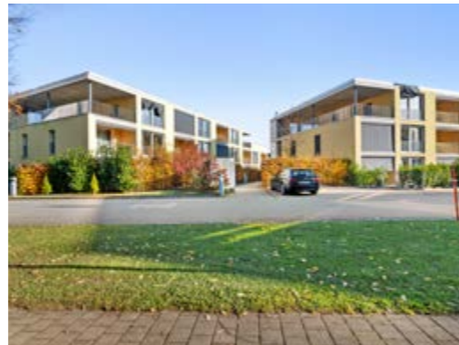
5035 Unterenfelden AG Hauptstrasse 7
