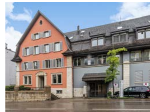
8200 Schaffhausen SH Grabenstrasse 15
