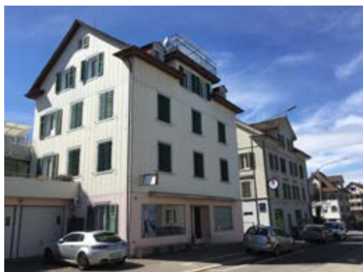
8800 Thalwil ZH Bahnhofstrasse 27 + 29
