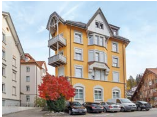
9000 St. Gallen SG Hagenbuchstrasse 31-31a
