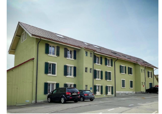
4513 Langendorf SO Heimlisbergstrasse 16/18
