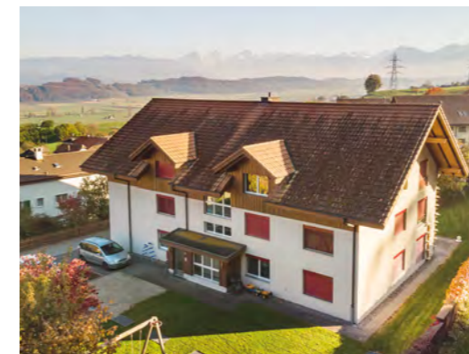
3128 Rümligen BE Rümligenstrasse 34/36
